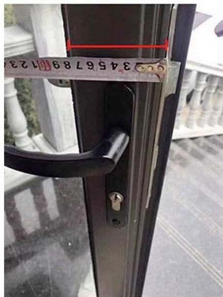
④ 测量门框宽度
