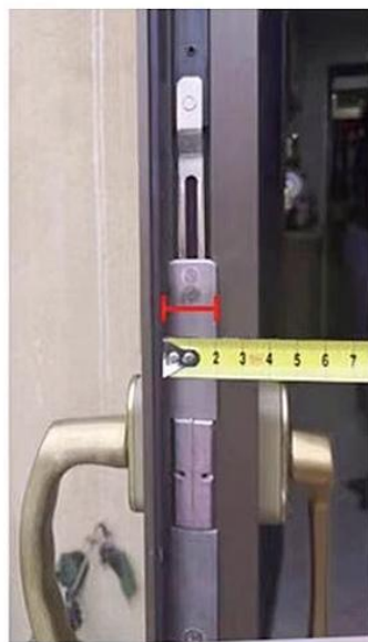
③ 测量导向片宽度
