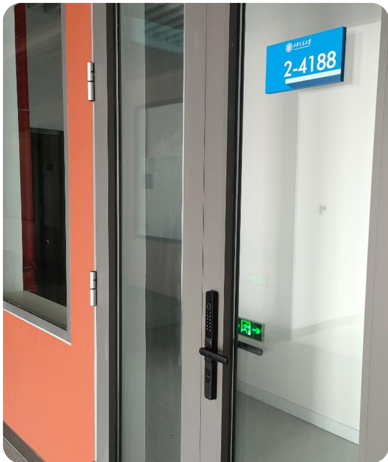
客户安装现场实拍
